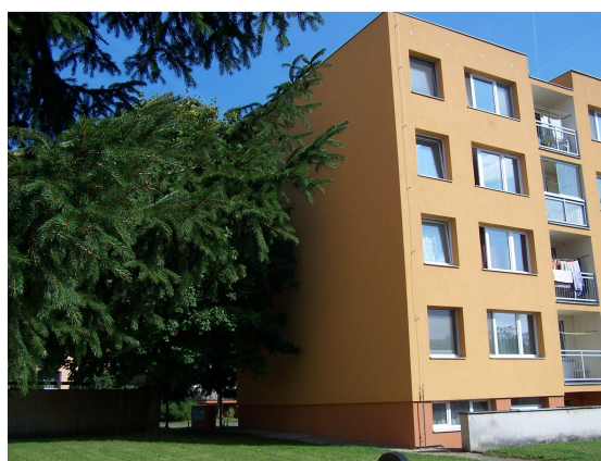
Boční severní fasáda
